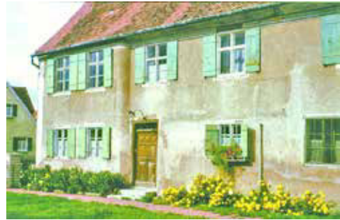
Das inzwischen abgebrochene Pfarrhaus von Holzkirchen [Foto: Hermann Greiner, Holzkirchen].
